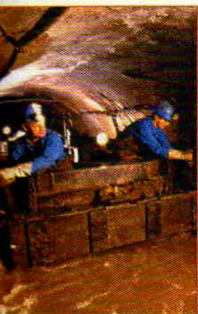
▲ En l'ombre et sous terre, les égoutiers travaillent en équipe avec des consignes strictes de sécurité et d'hygiène. Ici, une équipe manœuvre un bateau-vanne pour curer un collecteur.
